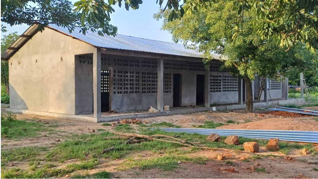
A Birao, les travaux de construction des bâtiments de 6 salles de classe se poursuivent grâce au soutien généreux d'Education Cannot Wait. @HCR
