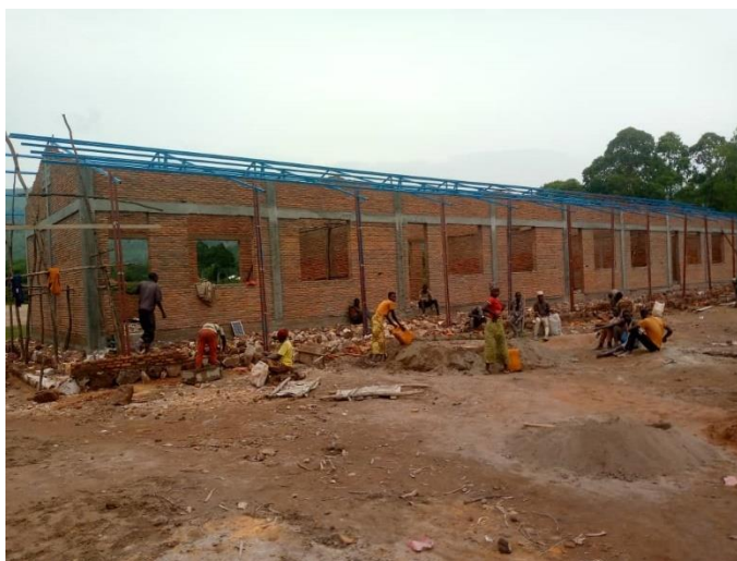
Travaux de construction en cours à l'école Butegeri à Giharo, dans la province de Rutana
