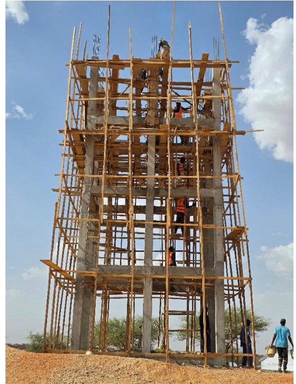
Construction du Château d'eau à K-Moura. © UNHCR/ Juillet 2026
