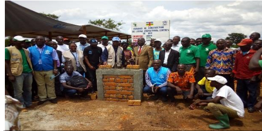
Pose de la première pierre de construction d'une école primaire à Obo. Ph UNHCR
