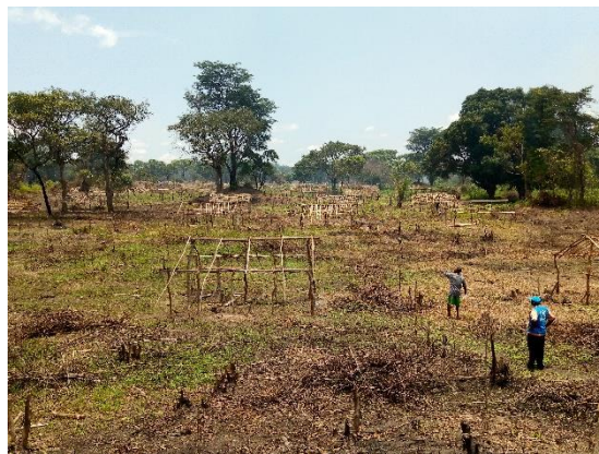
Des réfugiés centrafricains construisent des abris avec l'aide du HCR sur le terrain qui leur a été accordé par les autorités locales dans le Nord Ubangi. © HCR/Marianne Tshisamba
