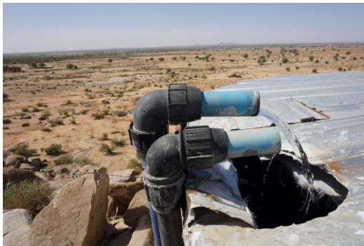
A borehole in Chad. © UNHCR / Pierre-Yves Rochat
