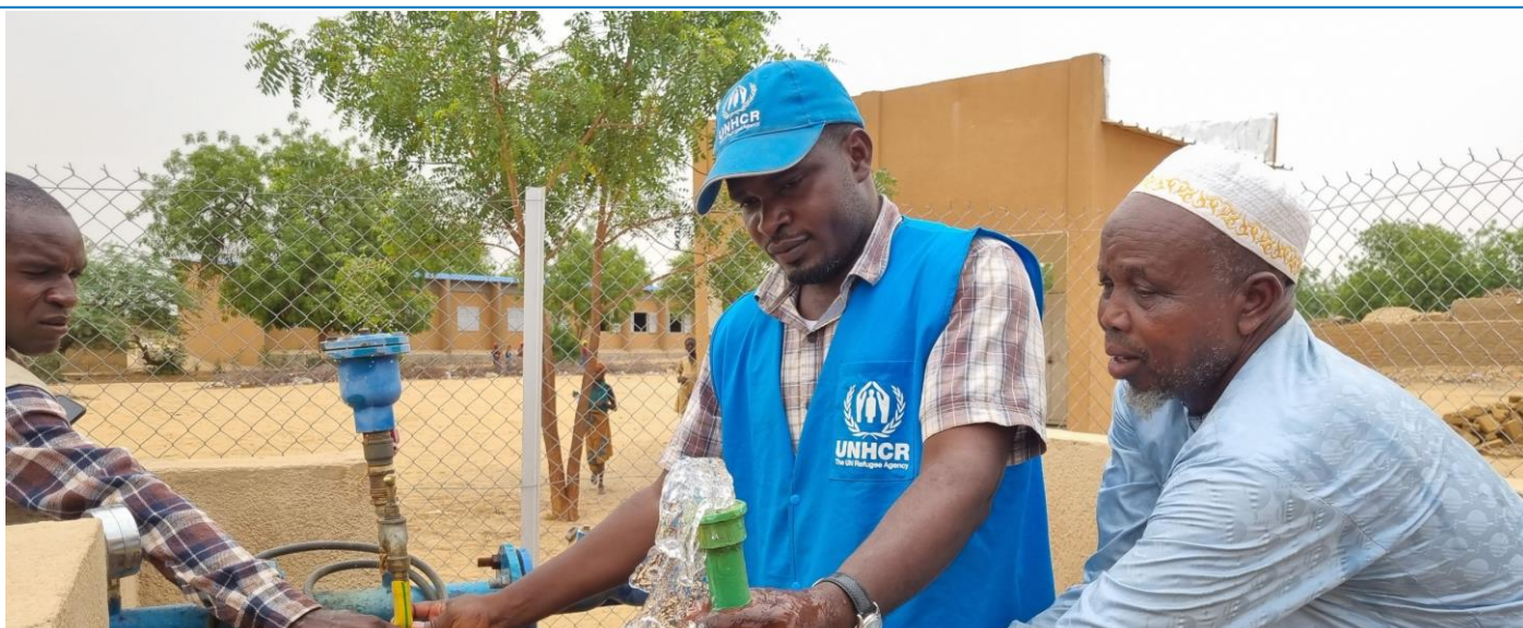
Le HCR renforce le système d'approvisionnement en eau pour garantir un accès adéquat à une eau saine aux personnes déplacées de force par les groupes armés dans la partie sud ouest du Nigeria pour trouver refuge à Kataguirri dans le département de Madaoua – région de Tahoua
