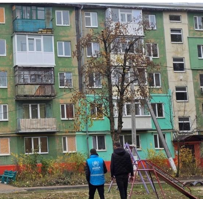
Багатоквартирний будинок у м. Павлоград Дніпропетровської області, в якому УВКБ ООН здійснювало відновлювальні роботи в місцях загального користування. © УВКБ ООН / Вікторія Тютюнник
