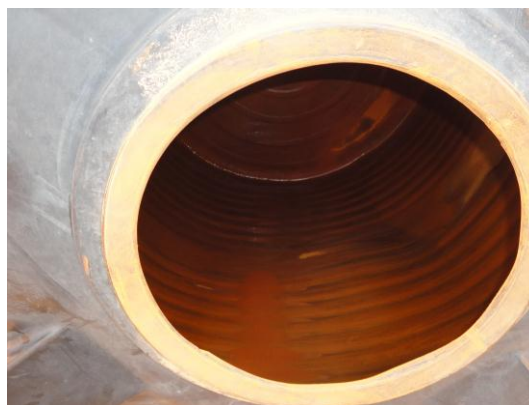
Polytank installé par World Vision couvert de dépôt de fer
