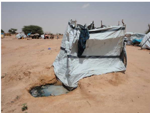
Douche inachevée construite par MSF CH
