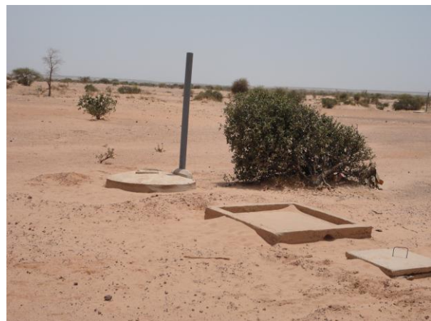
Latrine et douche inachevée construites par Plan Niger
