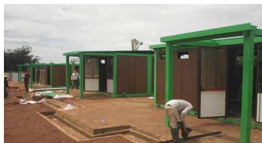
Assemblage des modules préfabriqués pour les salles de classe à Gado Ph. ADES
