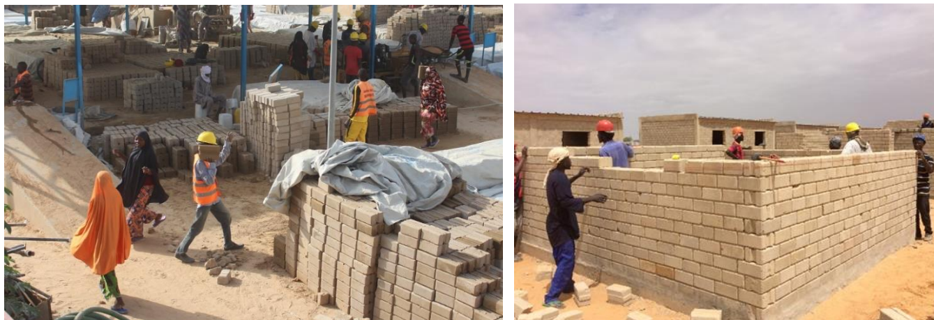
Gauche : Briqueterie dans la ville de Diffa (© UNHCR). Droite : Construction de logements à Assaga/Gueskerou (© UNHCR).
