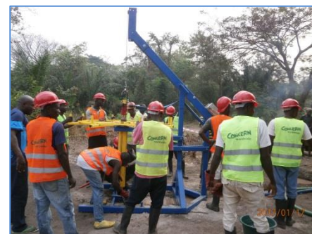
©VWW. Kouango, Préfecture de la Ouaka – Des ouvriers rénove un forage grâce à la technique innovante du « Village Drill ».
