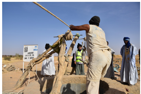
Les travaux d’excavation en cours à Guete Hemal. ©UNHCR/Helena Pes
