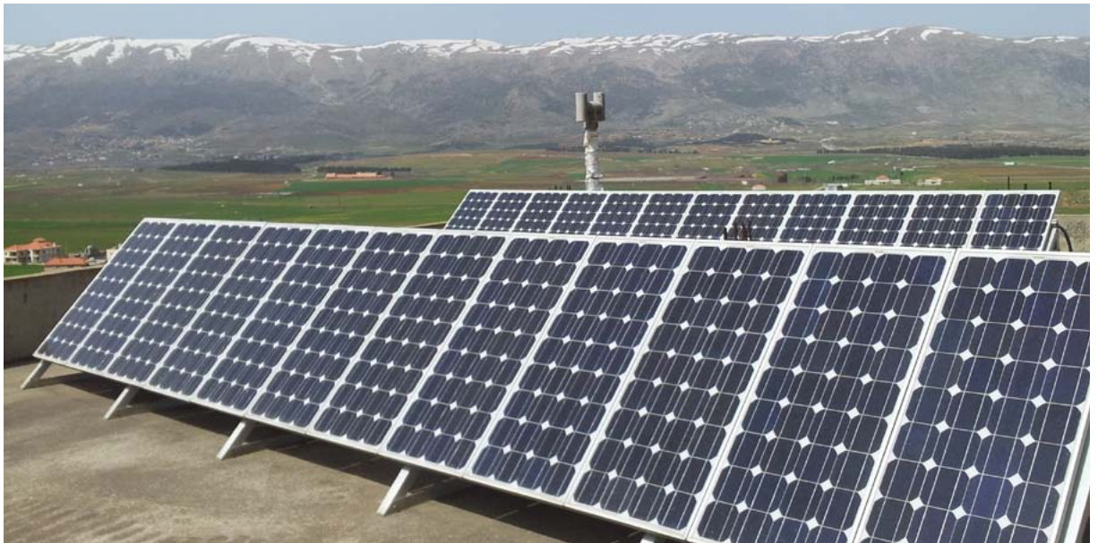
JebJennin municipality - West Bekaa
