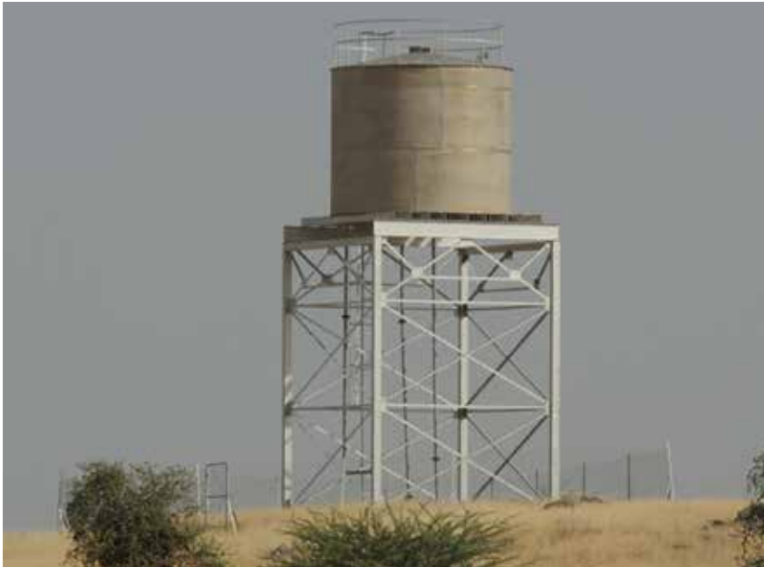
Figure 7: Château d'eau en INOX de 50m3 sur le site urbanisé pour les bénéficiaires (réfugiés maliens /autochtones) du site urbanisé d'Ayorou afin de faciliter l'occupation des abris construits sur les parcelles sociales.
