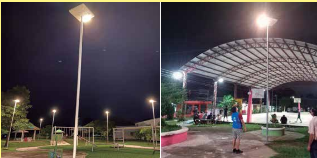
Las luminarias públicas solares donadas por ACNUR fueron instaladas en calles y parques de Tenosique para mejorar la seguridad en este municipio.
