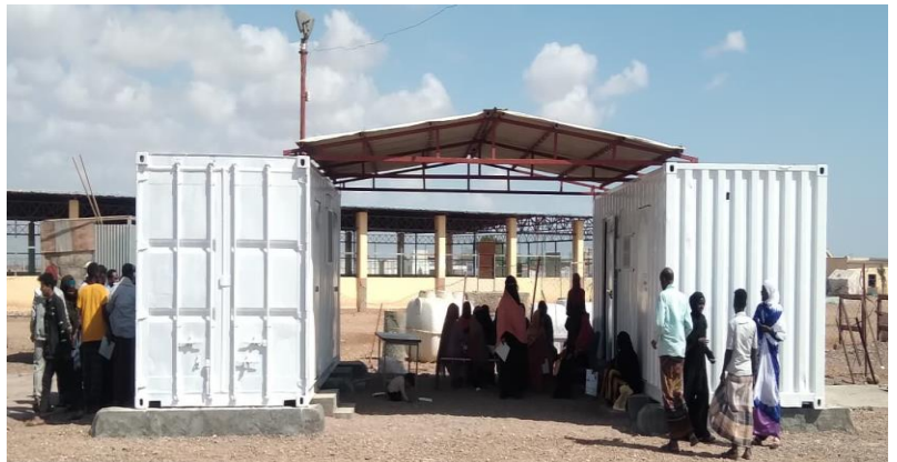
Le HCR a achevé la réhabilitation du centre de santé de Markazi @UNHCR
