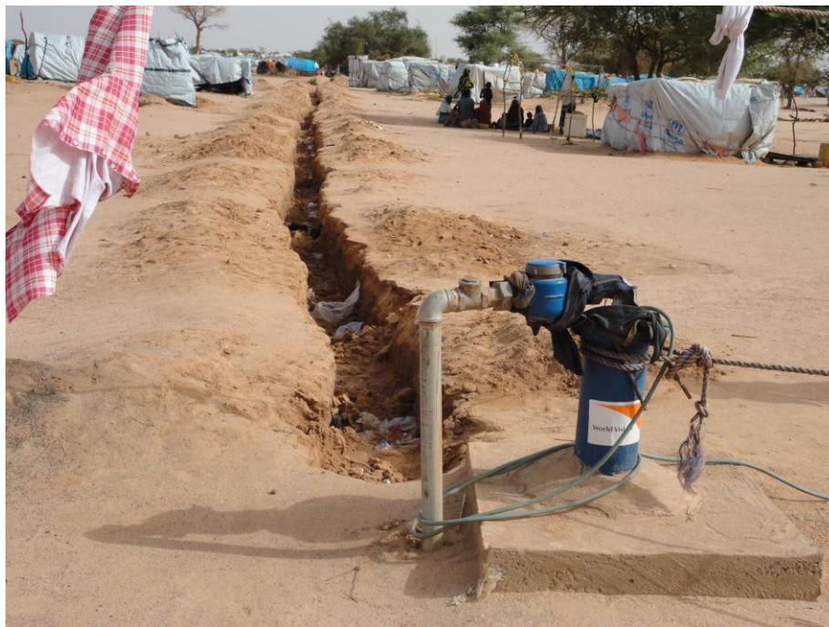
Tranchées pour la pose de conduites de l'extension
