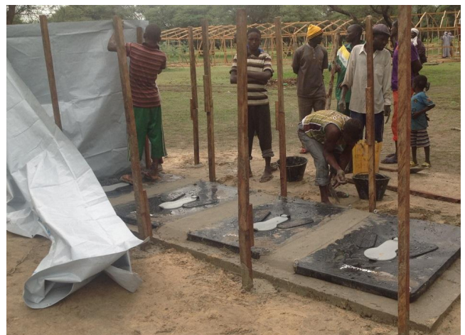
Constructions des latrines sur le site de Ngouboua . août 2014. HCR/Tchad
