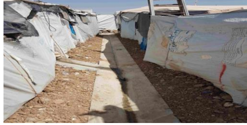
بناء قنوات صرف مكشوف جديدة خلف الملاجئ وعلى جوانب الطرق في مخيم Domiz 1 في دهوك. المفوضية السامية للأمم المتحدة لشؤون اللاجئين/ العراق / 2016
