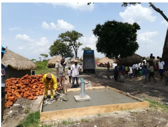
Construction d'un forage d'eau au site de Biringi. © UNHCR/C. Lopes
