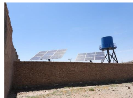
برنامه ایمن دأست میتنی بر محل کمیساریای عالی سازمان ملل متحد برای پناهندگان چاه ها را تعمیر میکند که توسط پمپ های میتنی بر برق آفتابی فعالیت میکند تا آب آشامیدنی پاک را برای جوامع عودت کننده و میزبان محیا سازد. © UNHCR/D.Corcoran
