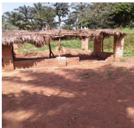
Hangar aménagé pour les cours
