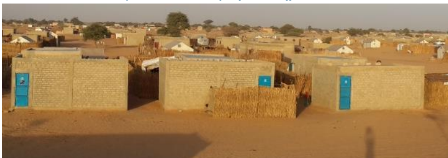
Maisons en technique de construction hydraforme à Diffa
