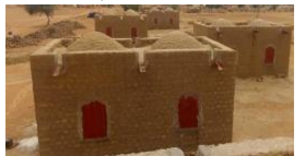
Maison en technique de construction sans bois à Chetimari
