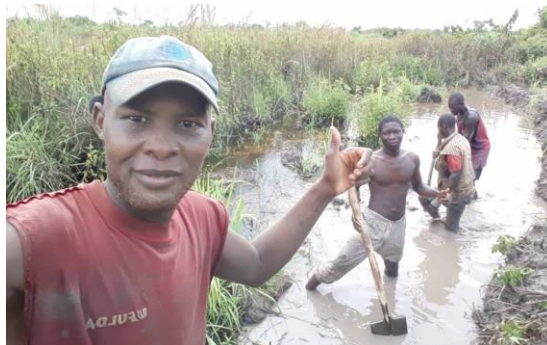
Réfugiés et membres de la communauté hôte en plein aménagement d'un étang piscicole à Mole, Sud Ubangi ©HCR/Wassy Tshikama
